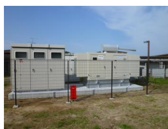
非常用自家発電機 設置
